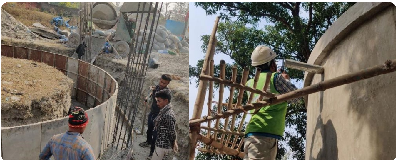
Inspection of the casting of collection tank at AMB division
